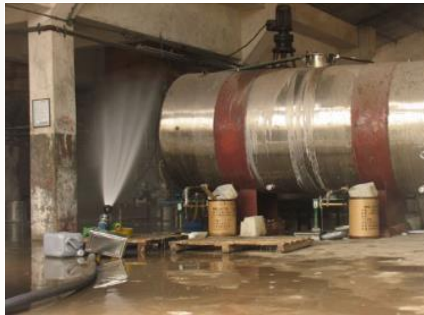
③ 监控屏上弹出现场视频
